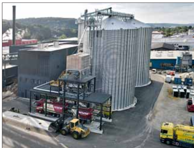
Pelletwerk mit zwei Silos und Verladung
