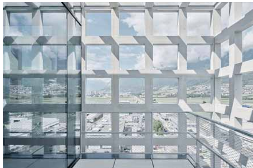
Der aufgesetzte „Kunstraum“ vereinigt sich von außen mit dem Bestandsbau zu einem Monolithen und gibt diesem ein besonderes Erscheinungsbild. Von innen bietet er Raum für Firmenveranstaltungen und aus 45 m Höhe einen Blick auf die Umgebung. Fotos: David Schreyer
