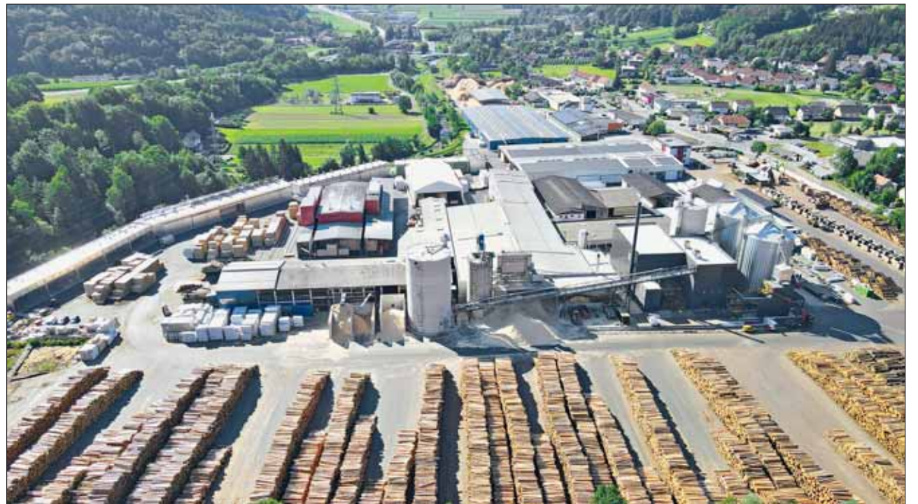
Holzheizwerk und Pelletwerk wurden so positioniert, dass Transportwege des Materials minimiert sind.
