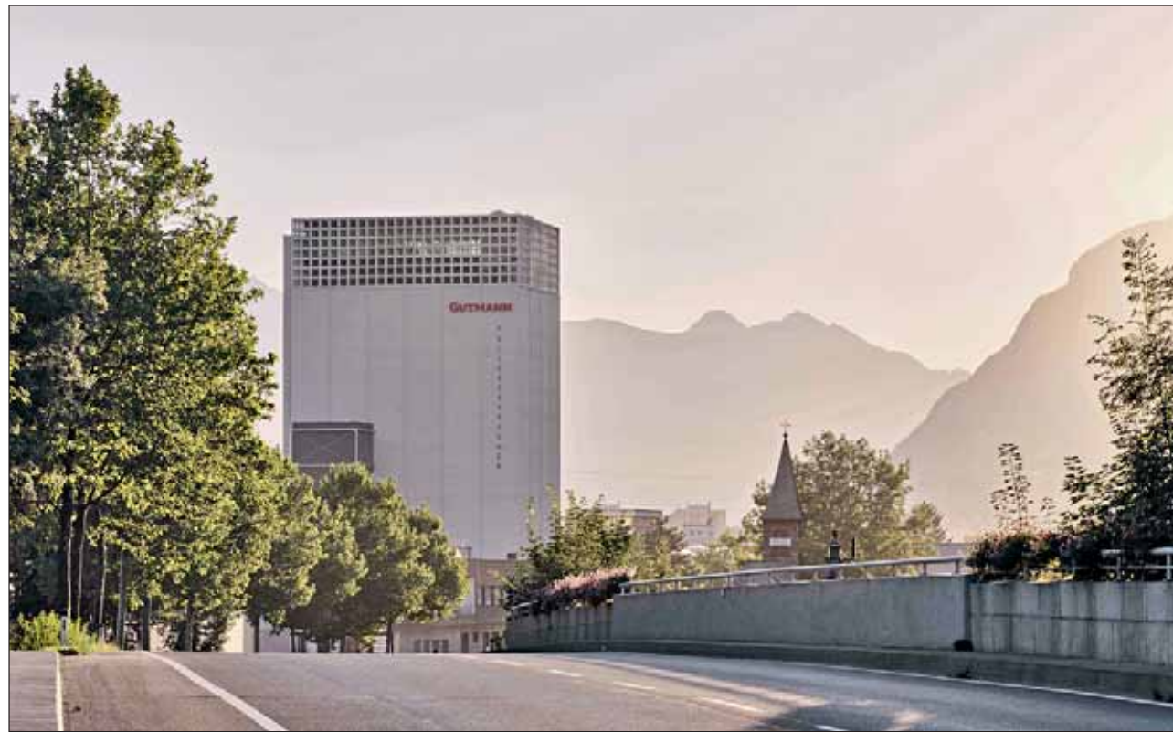
Aus einem sterilen Getreidesilo wurde eine Landmarke und ein Firmenwahrzeichen. Das Lager fasst 10 000 t Pellets.
