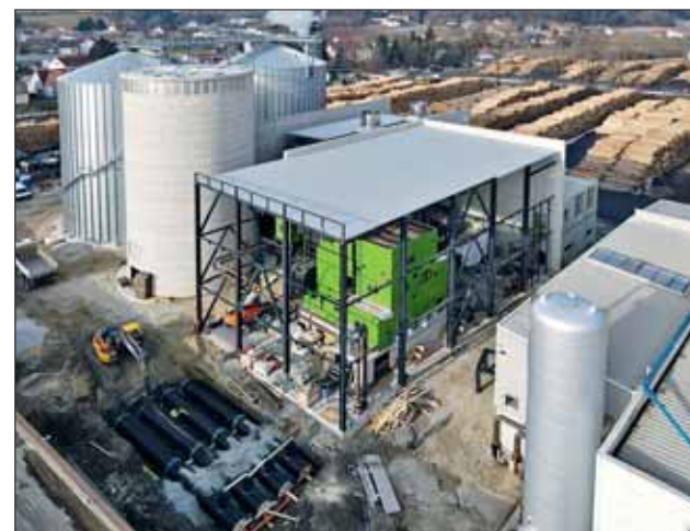
Blick auf den Kessel (Urbas) vor dem Schließen der Halle.
