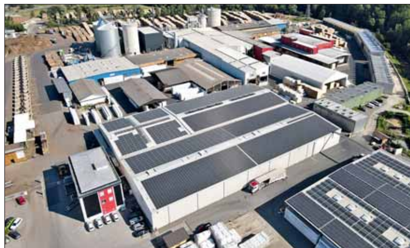
Einen bedeutenden Teil des nötigen Stroms erzeugt Rubner mit PV-Anlagen.
