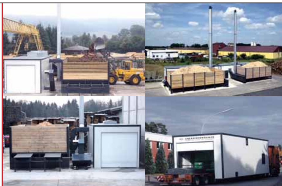
Unabhängig von Öl und Gas: Sowohl das Unternehmensgelände (oberer Bildrand) als auch die in der Nachbarschaft liegenden – aber zum Unternehmen gehörenden – Wohnhäuser werden mit Wärme aus der neuen Hackschnitzelheizung versorgt.
